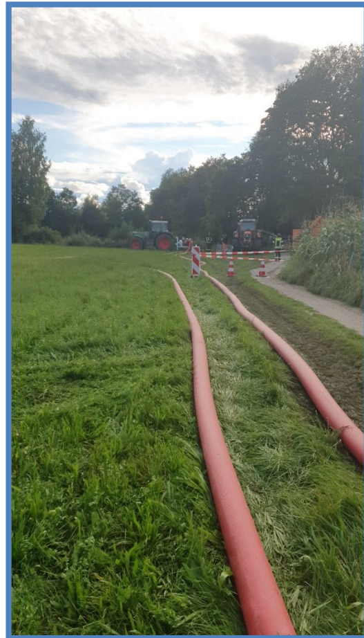
zusätzliche Abpumpstation am Überlaufbecken
