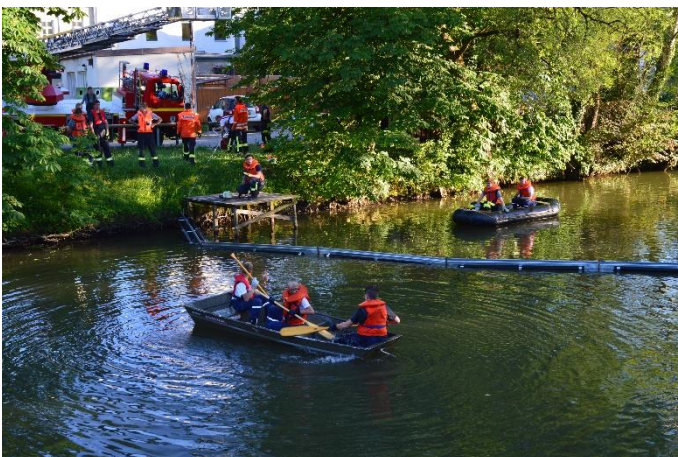
Aufbau der TAL-Ölsperre auf der Isen
