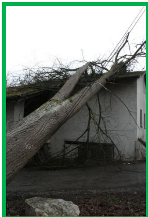
05.01. Baum auf Gebäude Kolpingstrasse
