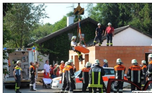
Personenrettung aus Baugrube 16.05.
